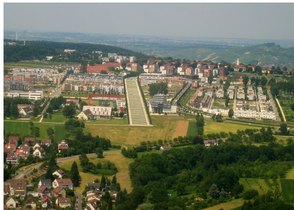
Scharnhäuser Park aus dem Flugzeug
